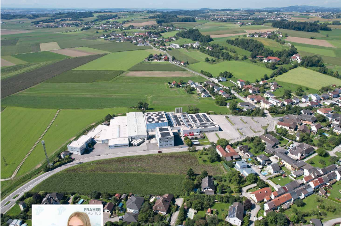
Der Hauptsitz des Unternehmens in Schwertberg, Oberösterreich.
